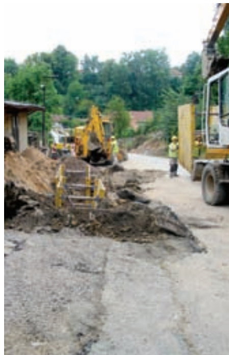
Pokládka kanalizačního potrubí u kamenictví
