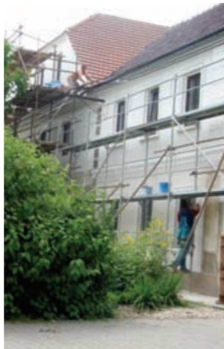
Opravu fasády stavení čp. 14 Urbánkovo provádí stavební firma Jan Večeře s. r. o. Dolní Újezd 572.
