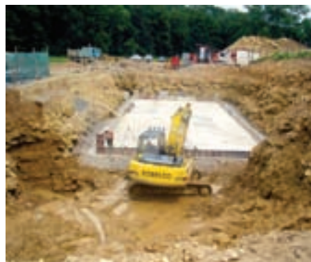
Betonování ve stavební jámě ČOV
